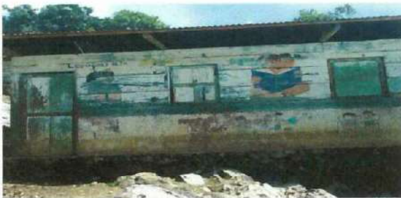
FOTO 5. Se necesita reparación de repello de paredes del Módulo No.3
